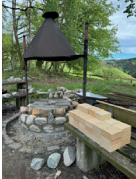
Wiederinstandstellungsarbeiten im Gange
